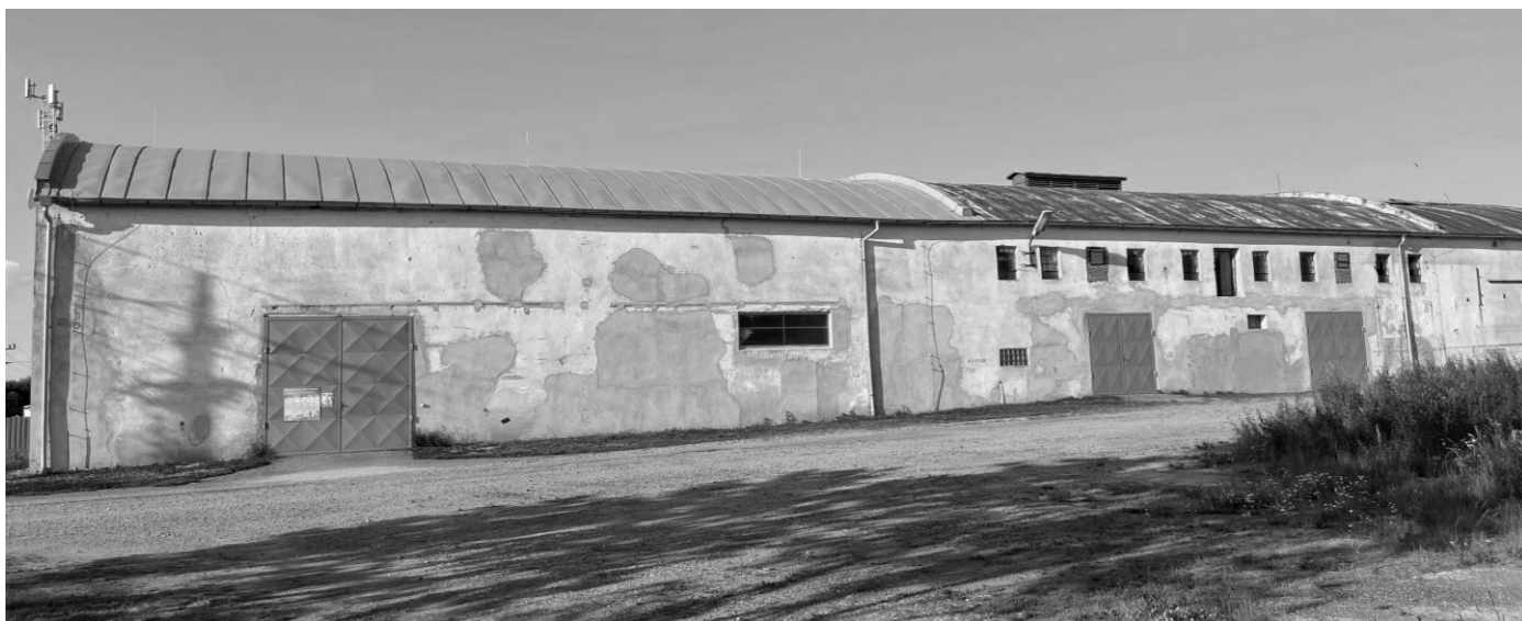
Budova nového sběrného dvora
