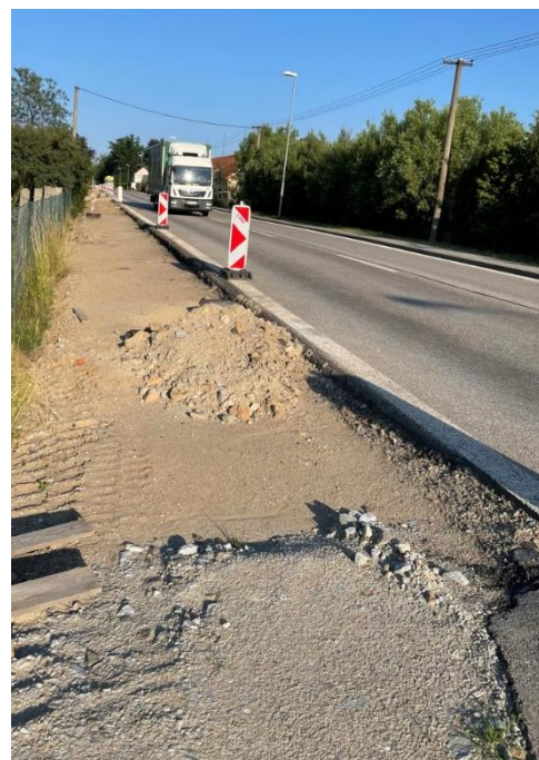
Započetí prací na chodnících v Třeboňské ulici
